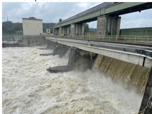
Kraftwerk Ryburg Schwörstadt bei Hochwasser © E.L. Arge Hochrhein
