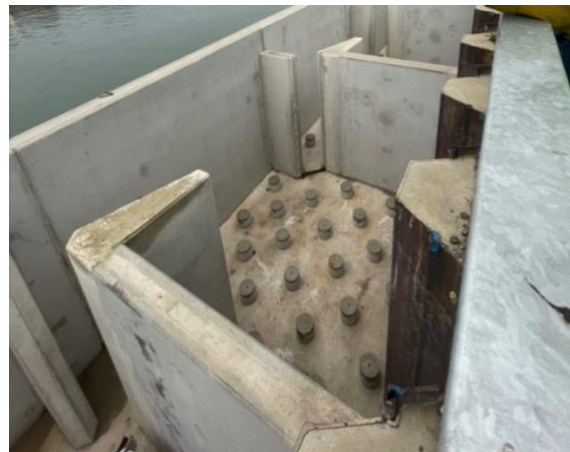
Die Sohle der Becken am Kraftwerk Rhinau wird mit Noppen strukturiert.
