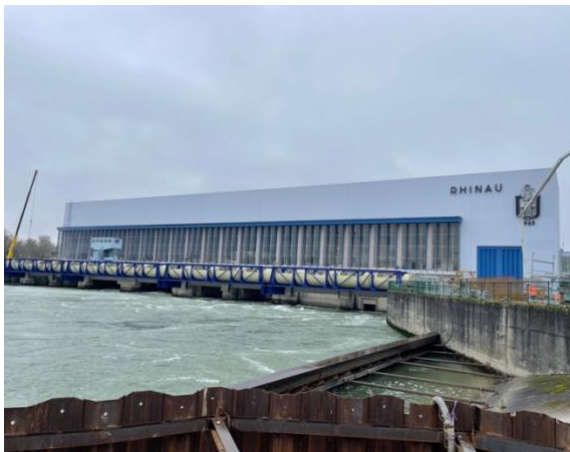
Die Bauarbeiten am Kraftwerk Rhinau sind weiter fortgeschritten.
